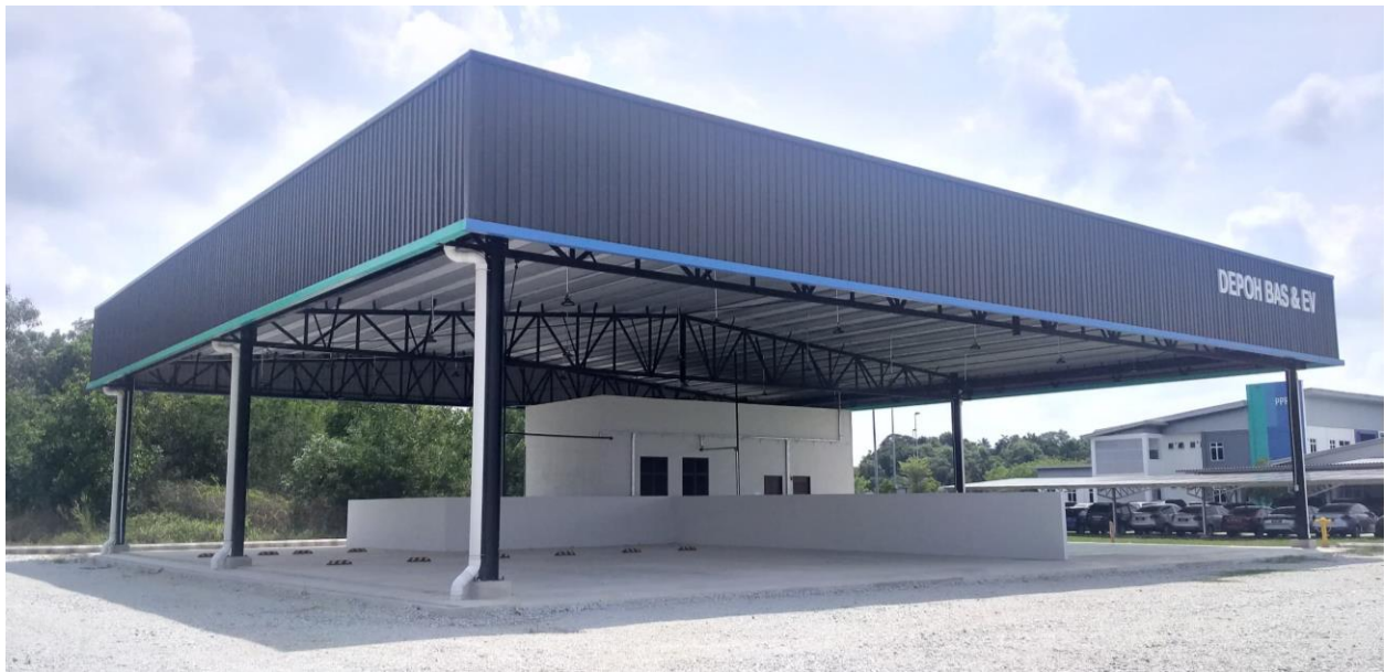
Stesen Pengecas Depoh Bas & EV UMPSA Pekan
